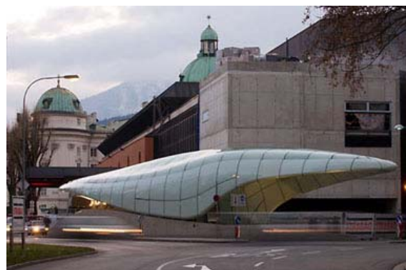
Figura 8 – Zaha Hadid: Estaciones del Nordpark Cable Railway. Innsbruck. Fuente: Arquitectura Viva , Nº. 114, 2007, pág. 90.
